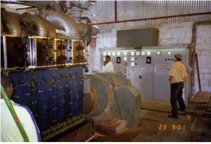
Production d'électricité en milieu rural à partir de bois. © Cirad, P. Girard.
