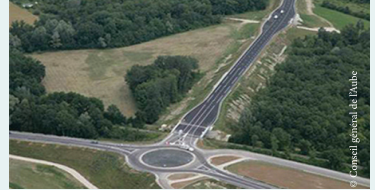
Vue aérienne de la rocade sud-est de Troyes
